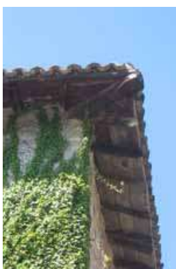
Forget débordant ancien sans gouttière.
