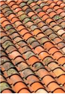
Toiture de tuiles creuses
