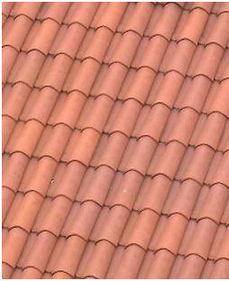
Toiture de tuiles romanes
