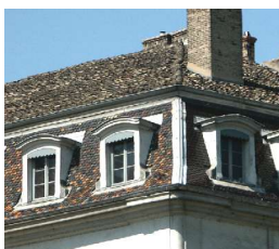
Toit « à la Mansart » en tuiles plates
