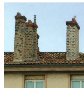
Souches de cheminées.
