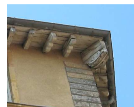
Traces de sculptures sur les chevrons (feuille d'acanthé) malgré la diminution du forget.
