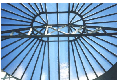
Verrière XIXe vue depuis l'intérieur.
